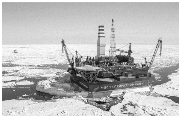
Рис. 6. Морская ледостойкая стационарная платформа «Приразломная» с кессонным основанием [15]
