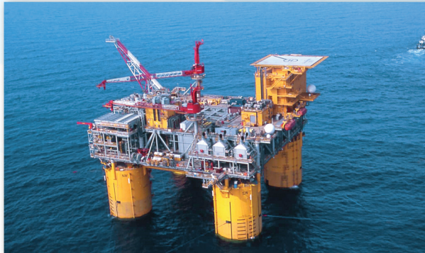
Рис. 2. Эксплуатация полупогружной платформы FPSU с распределенной якорной системой удержания
