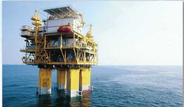
Рис. 3. Эксплуатация полупогружной платформы FPSU с системой удержания на натяжных связях (TLP)
