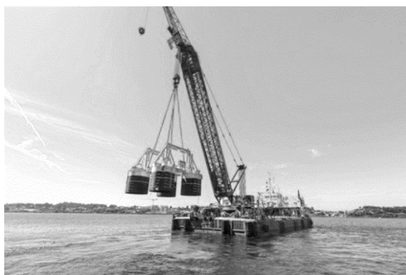
Рис. 5. Установка донной конструкции при помощи крана
