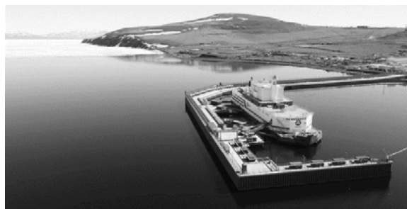
Рис. 4 Плавучая атомная теплоэлектростанция (ПАТЭС)
